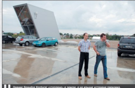
Данинас Браудас Konturai «утроплено» в землю, а на крыше устроили парковку.
